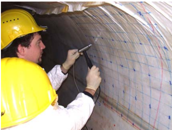
a) Messung im Kanal
