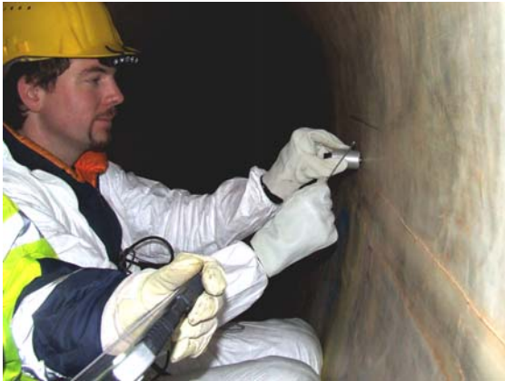
a) Messung im Kanal
