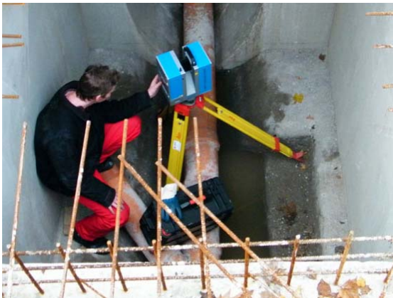
a) Vermessen des Startschachtes Abb. 3: 3D-Laserscanning (DMT, Essen)
