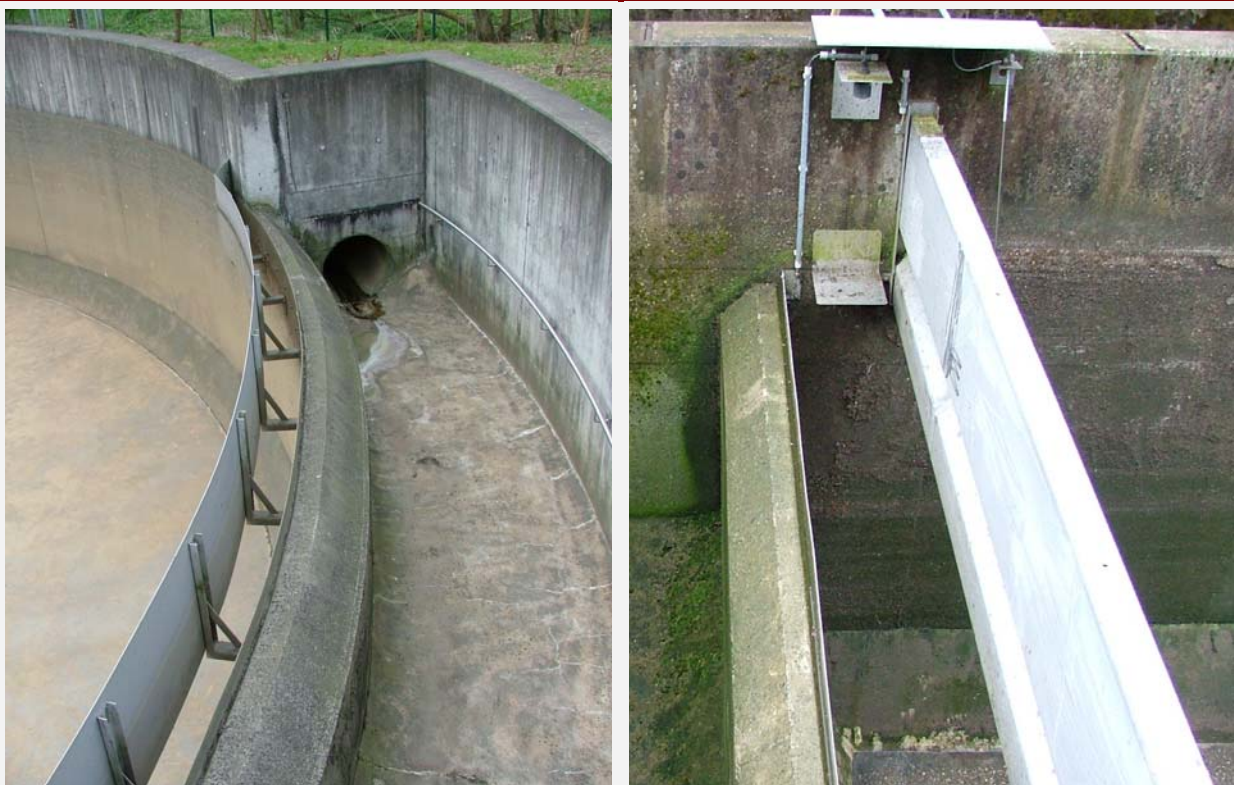
Abb. 1: Beispiele für scharfkantige und profilierte Entlastungsschwellen
