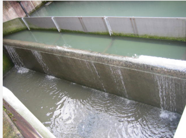
Abb. 1 (fortgesetzt): Beispiele für scharfkantige und profilierte Entlastungsschwellen
