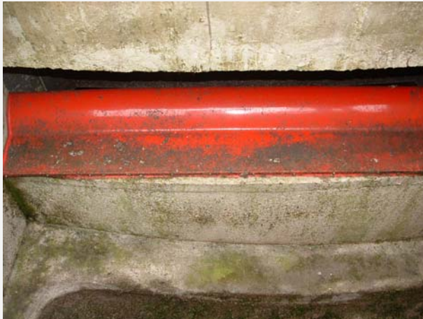
Abb. 1 (fortgesetzt): Beispiele für scharfkantige und profilierte Entlastungsschwellen
