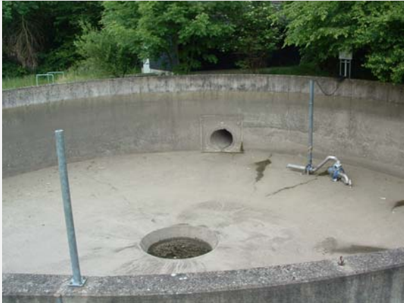
Abb. 9: Beispiele für die konstruktive Gestaltung der betrachteten Regenbecken
