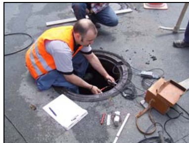
Abb. 6: Ultraschalluntersuchung mittels Ringmessung
