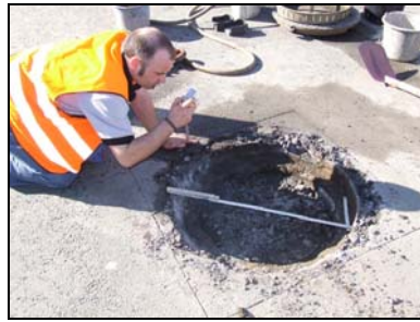
Abb. 3: Inspektion einer freigelegten Mörtelfuge
