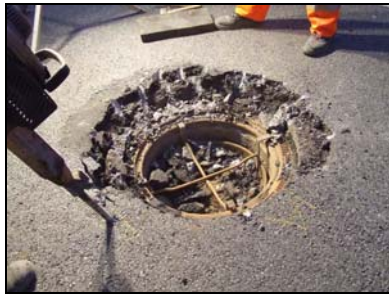
Abb. 2: herkömmliche Freilegung einer Mörtelfuge
