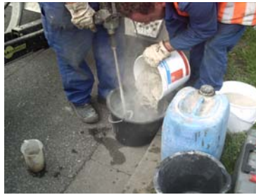
Abb. 20: 2. Arbeitsschritt: Mischvorgang
