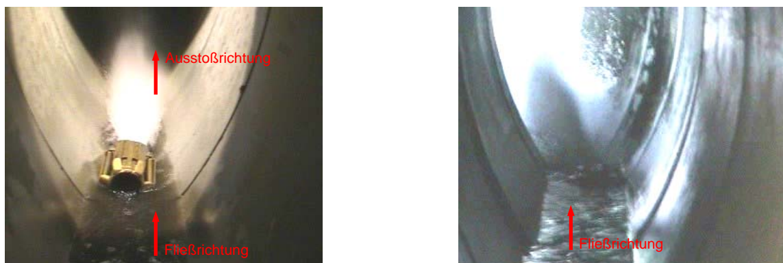
a) Ansaugöffnung der Ejektordüse, Absenkung des Wasserspiegels: von 20 auf ca. 12 cm
