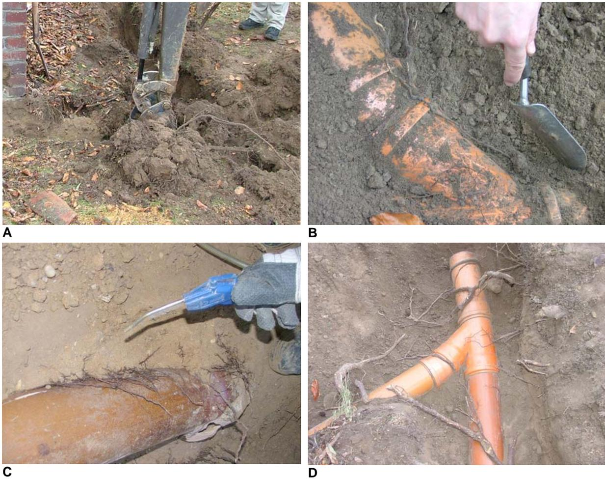
**Abb. 3:** Aufgrabungs- und Analysetechniken. **A** Aufgraben der Oberfläche und Aushub mit dem Bagger. **B** Freilegen des Leitungsbereichs von Hand. **C** Säubern der Wurzeln und der Leitungsoberfläche mit Druckluft. **D** Freigelegter Leitungsstrang.
