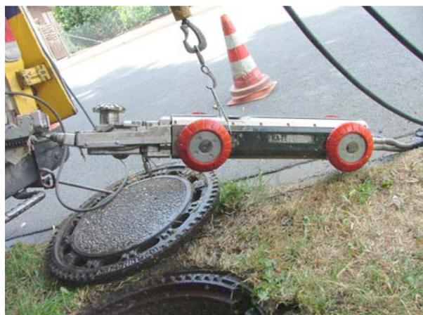
Abb. 10: Einbringen des Fräsroboters zur Wurzelentfernung in einen Schacht des Hauptkanals in der Schermbecker Straße in Raesfeld.
