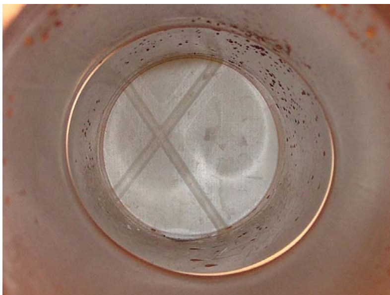
Abb. 3: Verformung der geprüften Rohrverbindung nach Einwirkung eines Prüfdrucks zwischen 3,0 und 3,5 bar.
