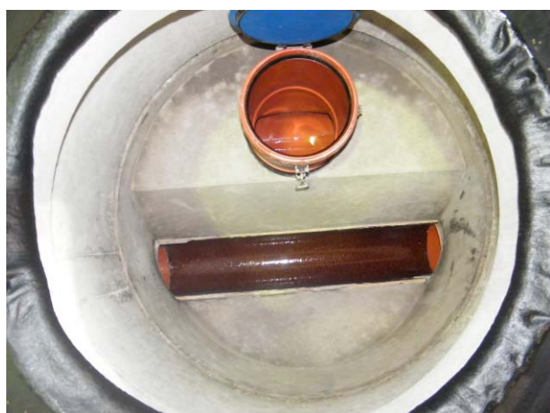
Abbildung 6: Blick in den Schacht
