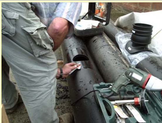
e) Reinigung der Schweißfläche
