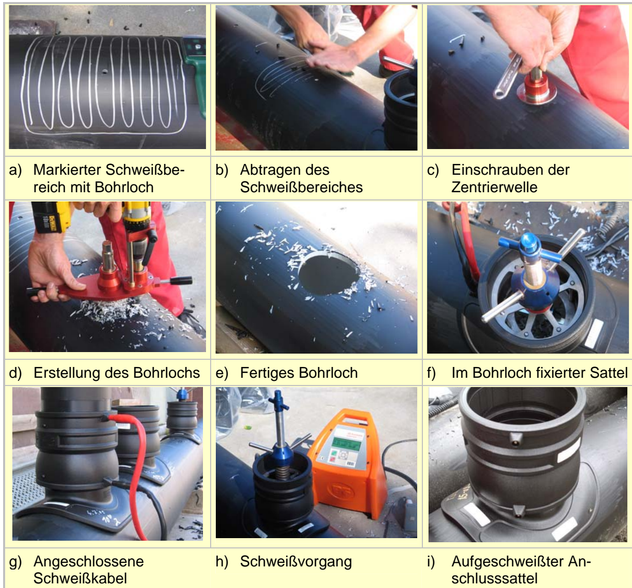
Abb. 2: Einbau des PLASSON LightFit Anschlussattels
