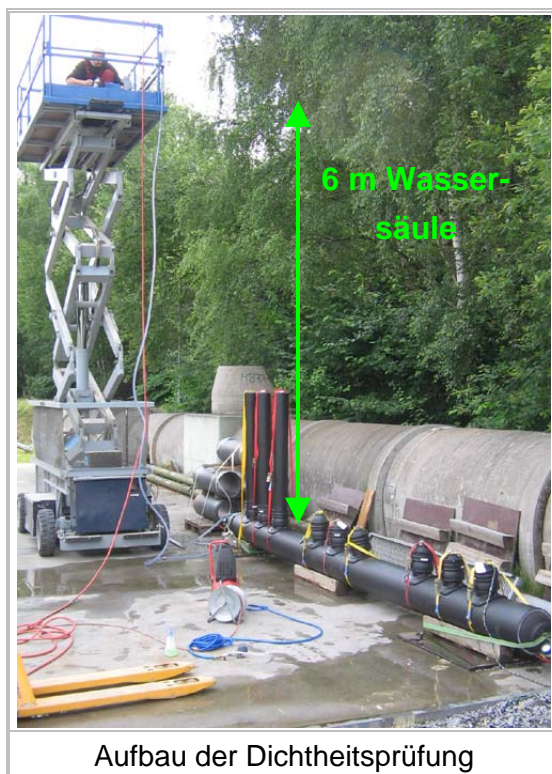
Abb. 3: Dichtheitsprüfungen nach Einbau
