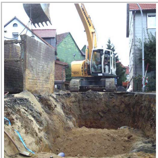
Abb. 10: Baustelle in Frielendorf-Lenderscheid
