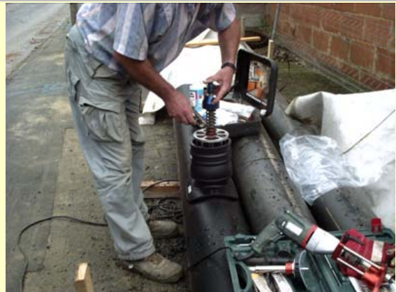
f) Befestigung des Sattels im Bohrloch
