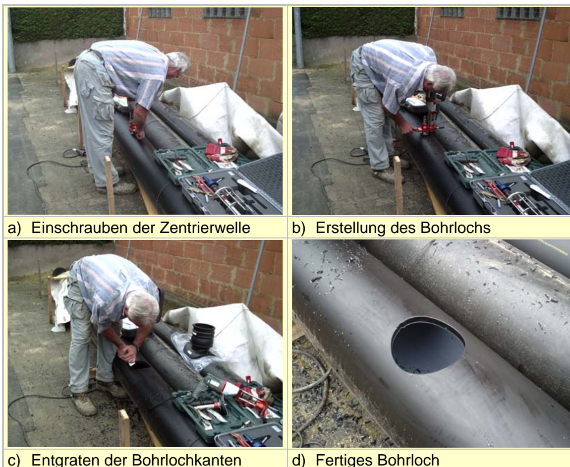
Abb. 11: Einbau auf der Baustelle in Frielendorf-Lenderscheidt
