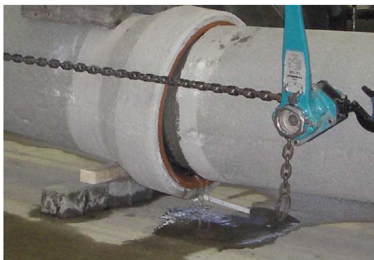
Bild 3 Prüfungsdurchführung: Undichtigkeit bei einer Abwinkelung von 120 mm/m
