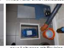
...neue Leitungen mit Revision
