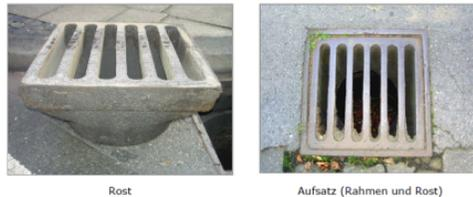
Bild 30: Aufsatz (Typ II) für Straßenabläufe nach DIN 19583-1 [101, 22<sup>16</sup>]
