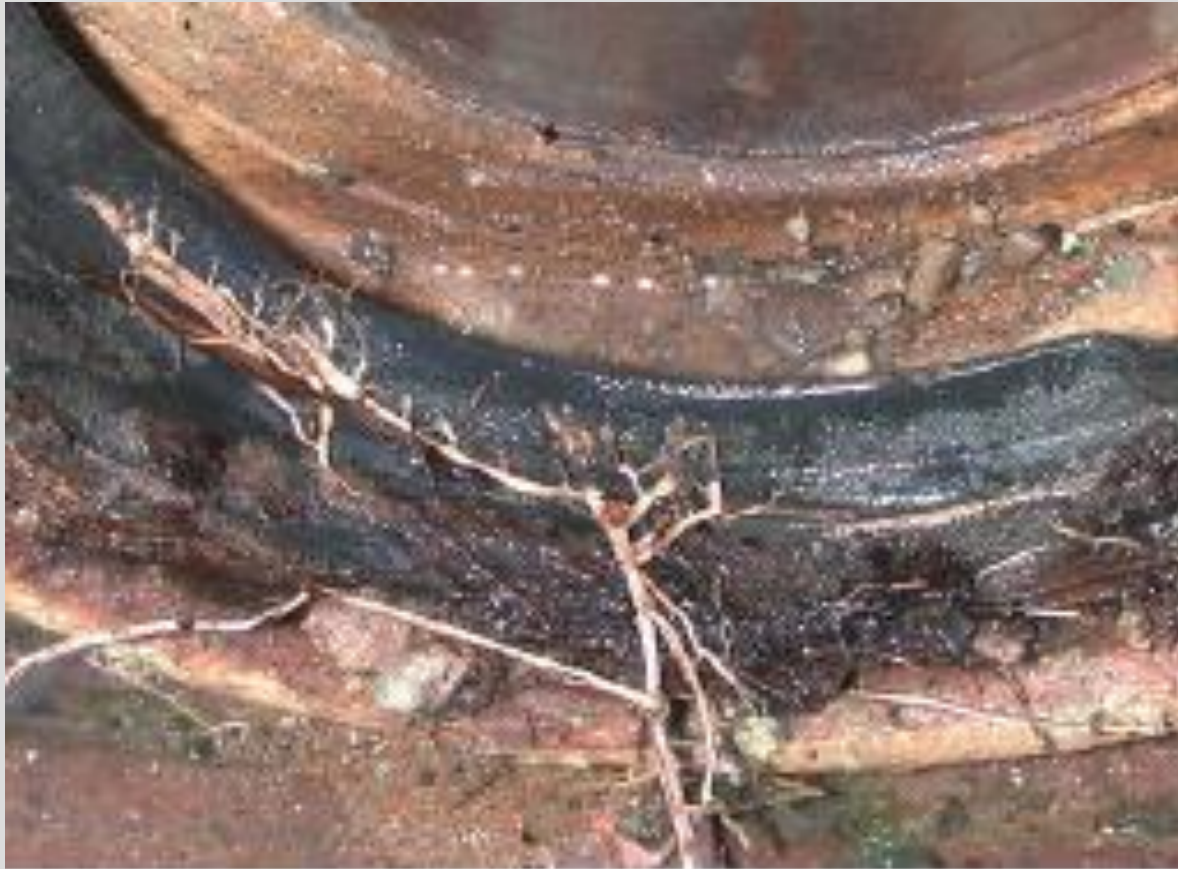
Abb. 61: Die Wurzeln sind nicht über die Lichtlippe der Steckverbindung in den Leitungsquerschnitt gewachsen. Sie sind entlang des Elastomer-Dichtelement quer um die Leitung gewachsen.
