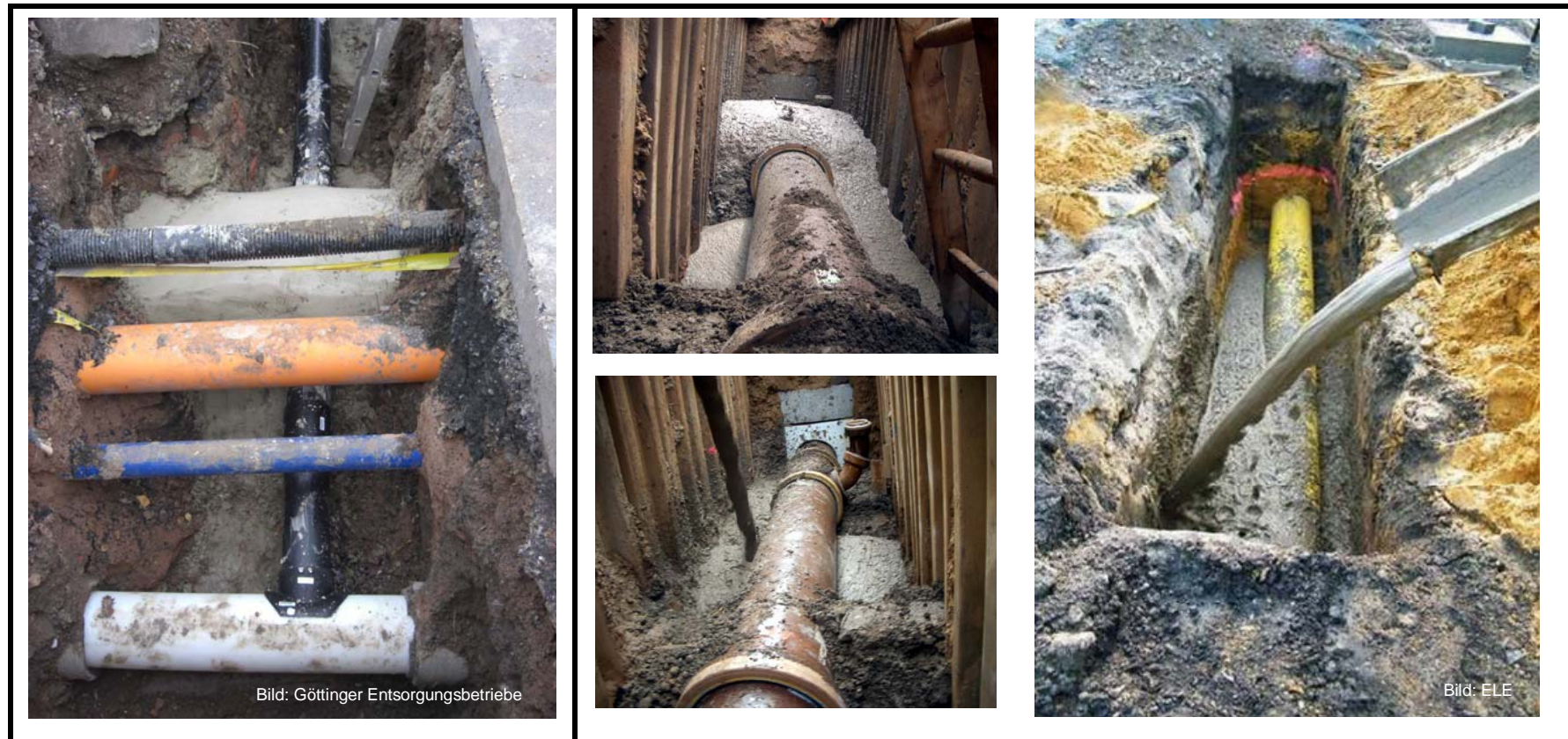
Abb. 1: linke Abbildung: Platzmangel durch verschiedene Ver- und Entsorgungsleitungen [1], mittlere und rechts Abbildungen: Einsatz von fließfähigem Bettungsmaterial bei der Leitungsverlegung
