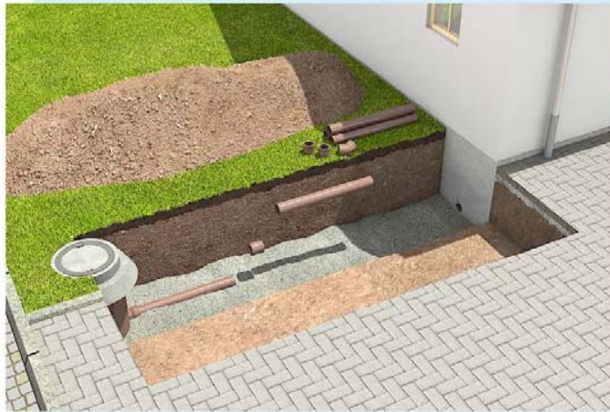
Erneuerung in offener Bauweise
