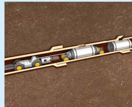
Innenmanschetten Positionierung der Manschette mit dem Kamerawagen (nur bedingt einsetzbar, da nur sehr eingeschränkt bogengängig)
