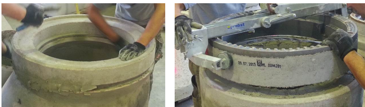
Bild 4 Aufsetzen eines Ausgleichsringes mit Verschiebesicherung auf den Adapterring (links); Aufsetzen des Rahmens der Schachtabdeckung auf einen Ausgleichsring mit Verschiebesicherung (rechts)
