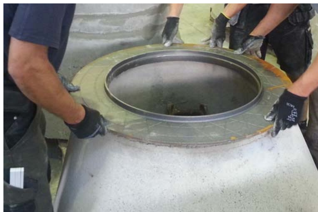
Bild 2 links: Ansicht des Adapterringes rechts: Einbau eines Adapterringes auf einen glatten Konus ohne Verschiebesicherung
