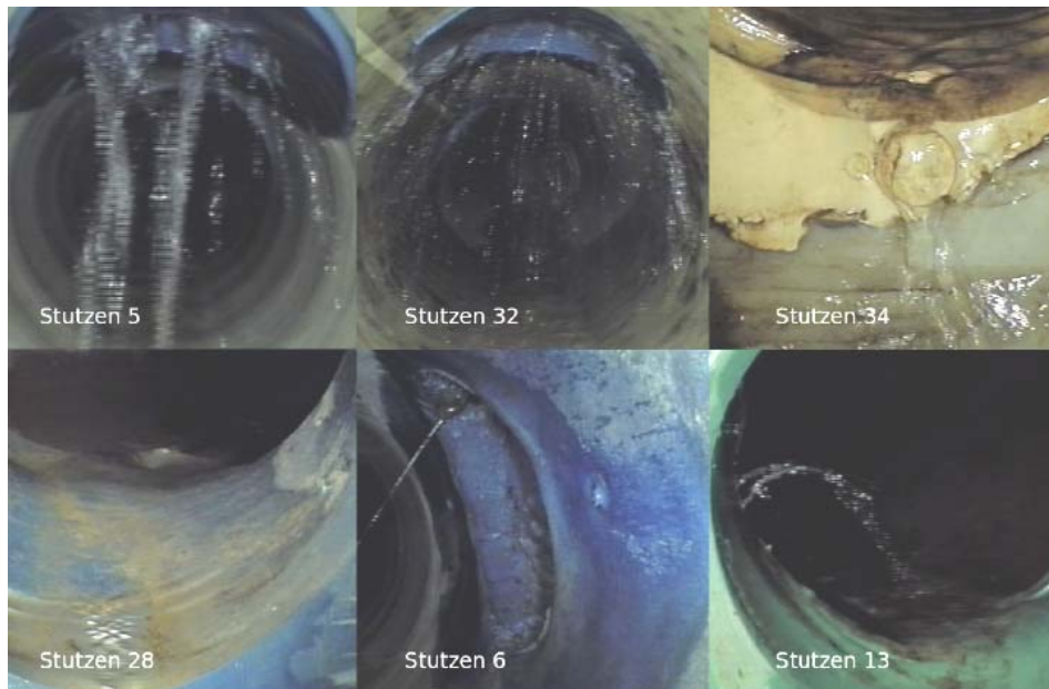
Bild 9 Bilder zur Klassifizierung der Infiltrationsmenge, aus IKT-Großversuchen
