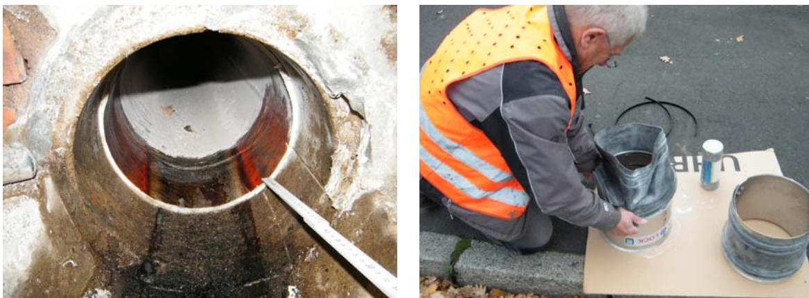
Bild 6 Für einen Manschetten-Einsatz vorbereiteter Bereich mit etwa 14 Zentimeter zurückgeschnittenem Nadelfilzliner (links); Vorbereitung der Spannhülse und Einreiben der Gummi-Manschetten mit Talkum (rechts)
