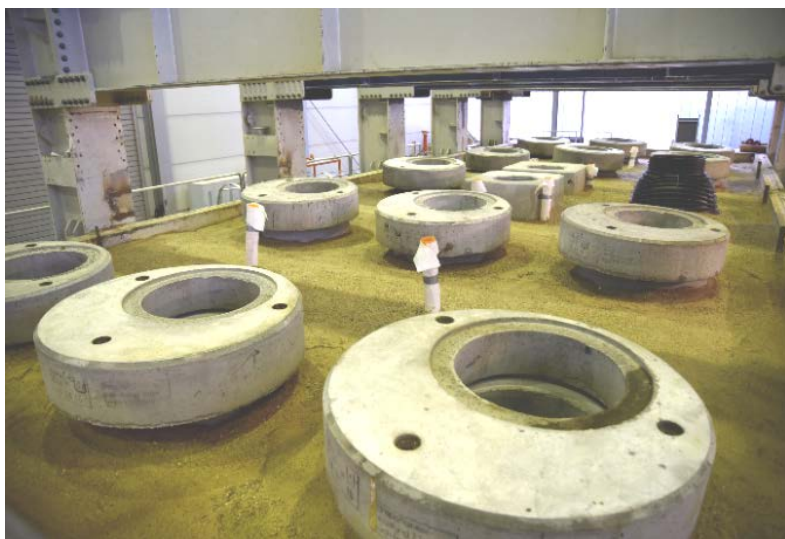
Bild 6 Ansicht der aus dem Großversuchsstand herausragenden Schachthälse mit zusätzlich aufgelegten Abdeckplatten zur Auftriebssicherung
