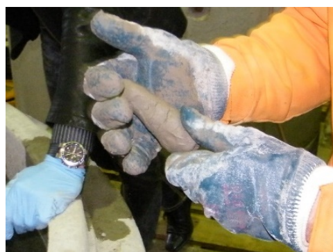
Bild 5 Beispiel für die Ermittlung der Infiltrationsmengen mittels Messbecher und Stoppuhr (links) und Formen eines Abdichtungs-Pfropfens (rechts)
