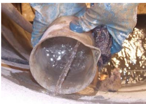
Bild 5 Beispiel für die Ermittlung der Infiltrationsmengen mittels Messbecher und Stoppuhr (links) und Formen eines Abdichtungs-Pfropfens (rechts)
