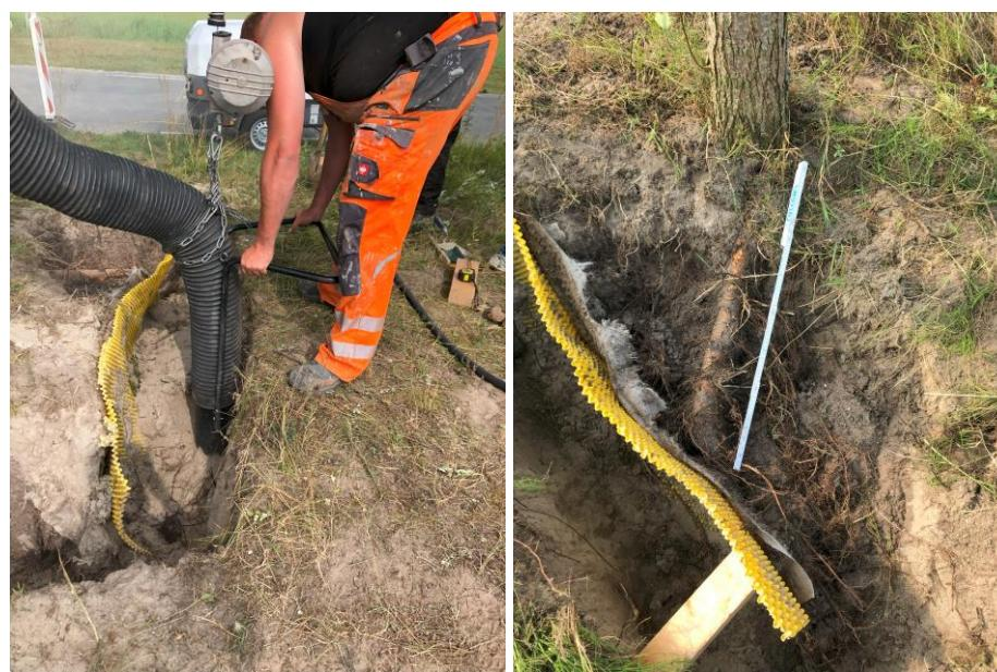
Abbildung 6: Beispielhaftes Vorgehen zur Erstellung der Untersuchungsgräben an den Baumstandorten (Links: Einsatz des Saugbaggers mit Druckluftlanze nach Entfernung der Grasnarbe, Rechts: Abstützung eines seitlichen Untersuchungsgrabens)
